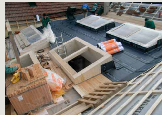
Lichtschächte in der Bauphase
