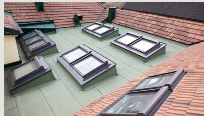
Hofüberdachung nach Lokalerweiterung
