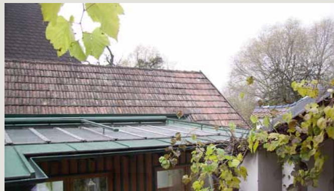
Innenhof vor der Erweiterung
