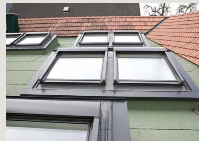
Das fertige Dach
